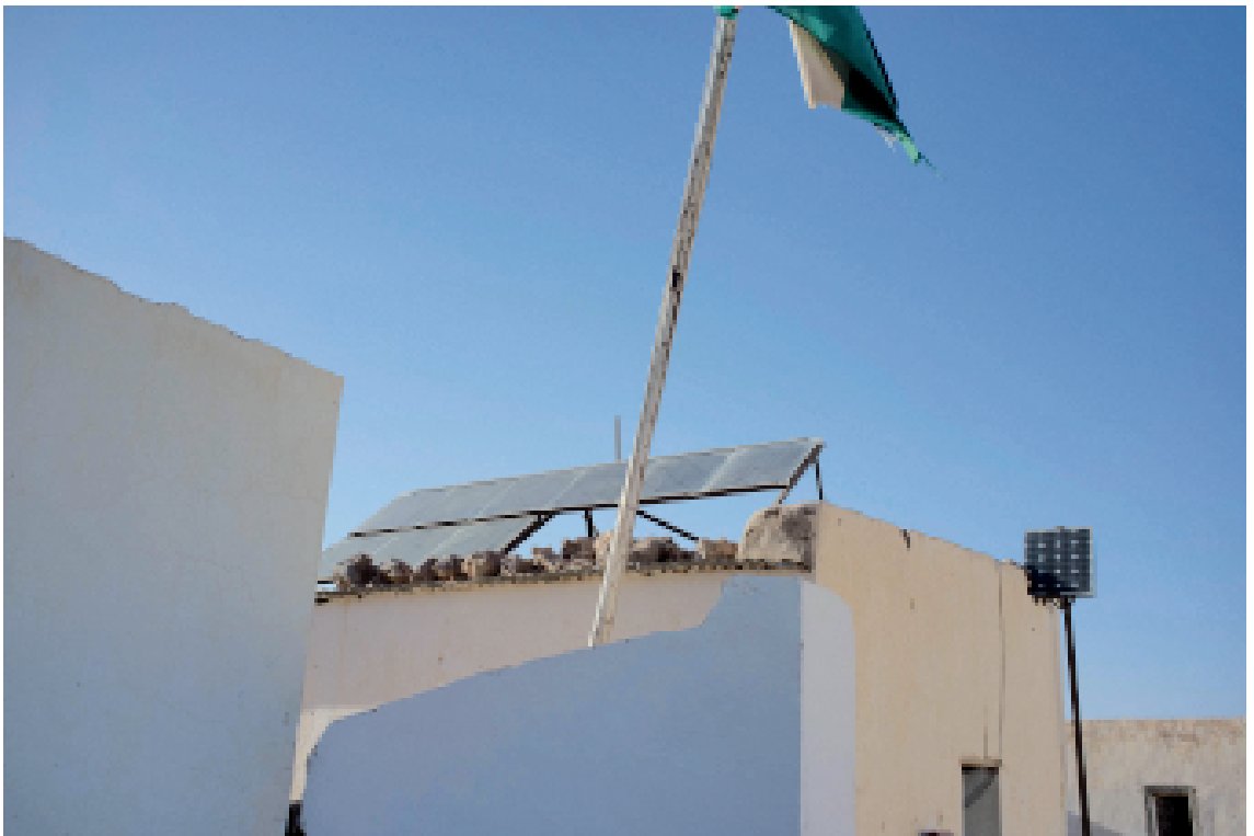
Installation de l'ADER/S sur un dispensaire.
