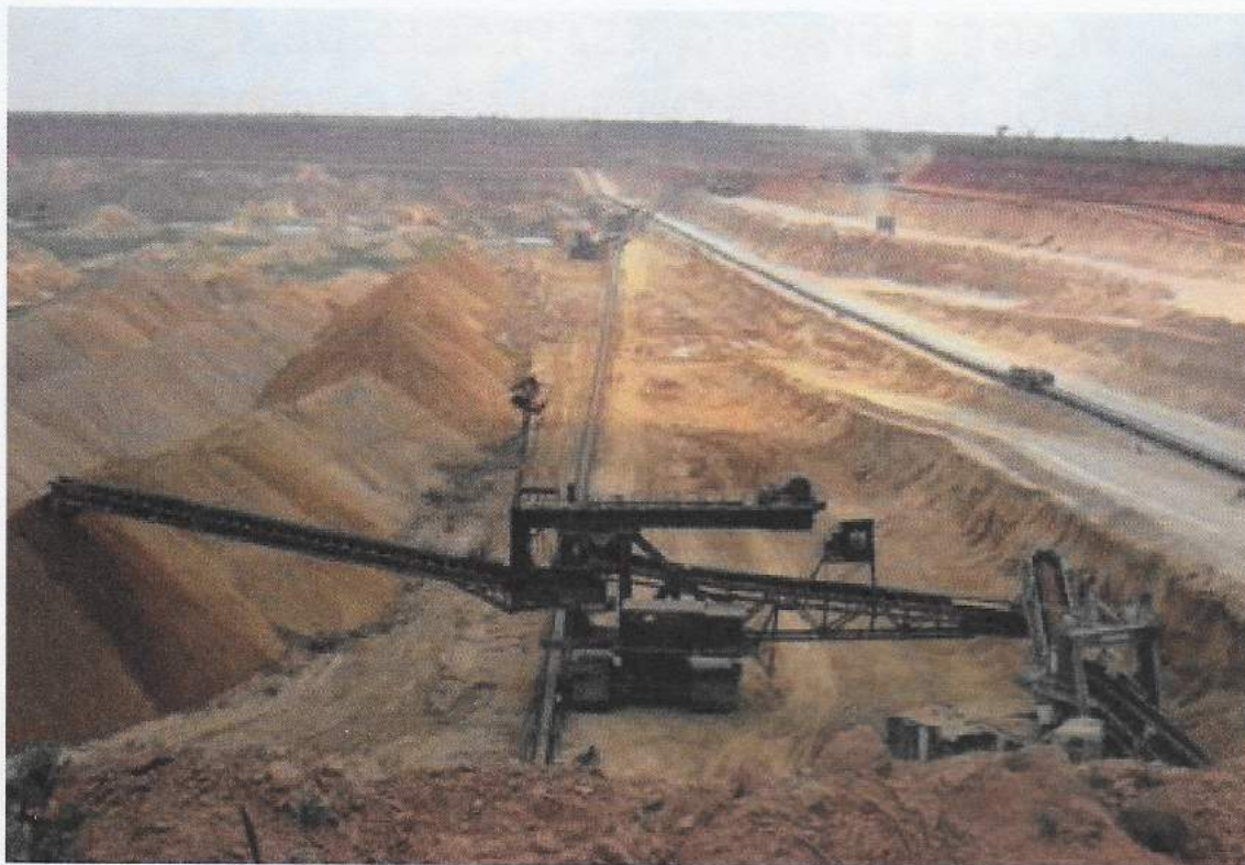
Chantier d'extraction du sable.
