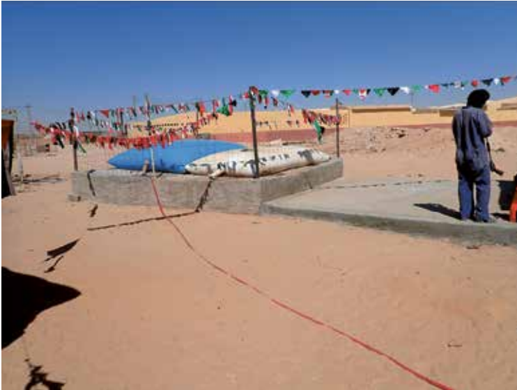
Installation du lieu de nettoyage des couvertures et des tapis : les réservoirs d'eau, la place pour les étendre et les laver. Photo: SP
