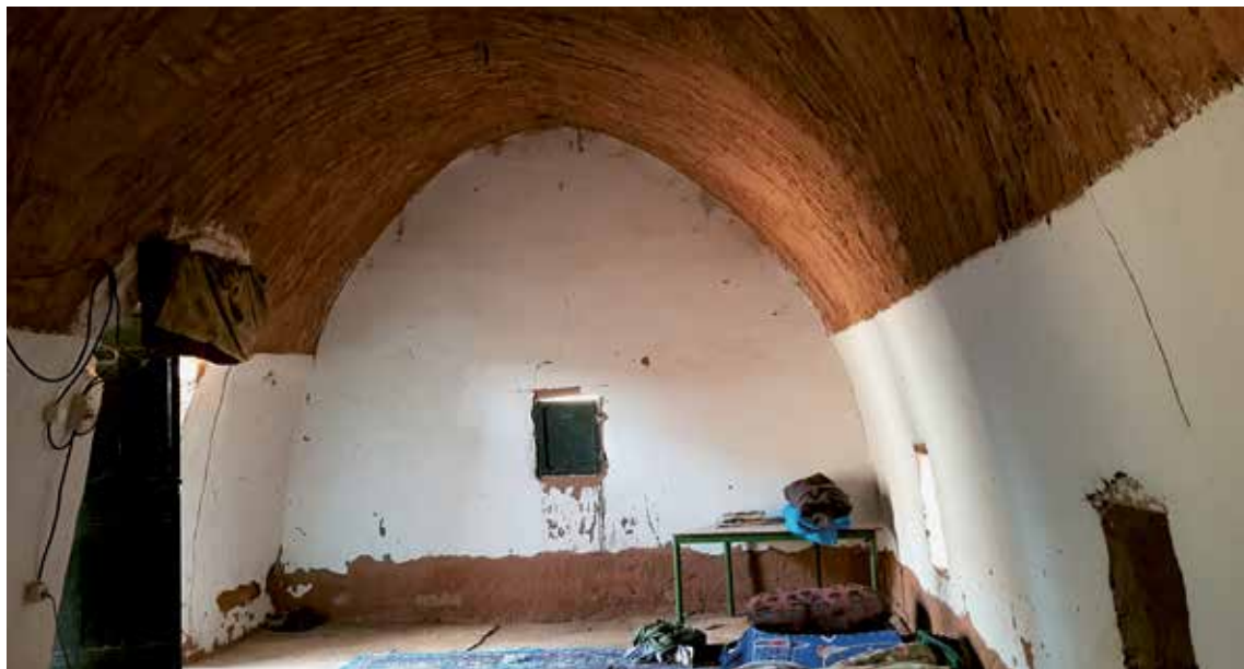
Maison en terre et voûte nubienne dans les camps, modèle pour la construction du dispensaire.
